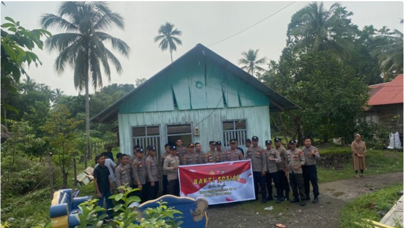
Tampak Memprihatinkan kondisi rumah warga Desa Bente yang dibedah Polres Morowali
